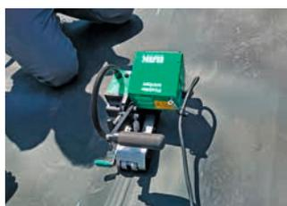
La piccola e leggera saldatrice a cuneo compatta per saldare tutti i diversi tipi di geomembrane termoplastiche. La posizione della macchina è nota con l'app myBAK.
